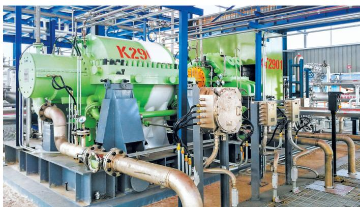
丙烯压缩机在“齐鲁石化-胜利油田百万吨级CCUS项目”运行。(重庆通用工业(集团)有限责任公司供图)
