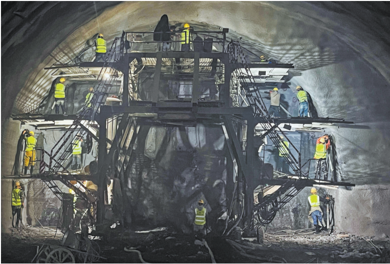
施工人员在隧道内施工。（中铁十二局供图）
