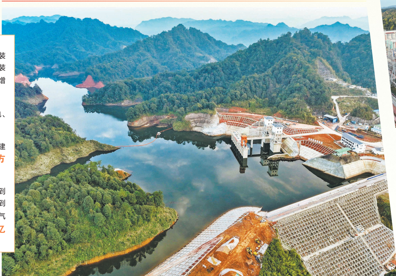
▲位于綦江中峰镇的蟠龙抽水蓄能电站上水库。 ►中石化涪陵白涛集输站,工作人员在巡检管道。(摄于2025年3月25日)
