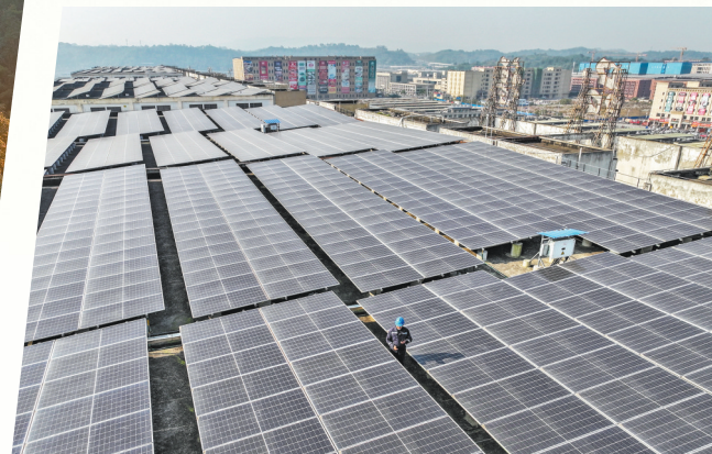
▲重庆高新区石板镇重庆明品福冻品市场屋顶,工作人员正在巡检光伏板(摄于2024年12月31日)。 首席记者 龙帆 摄/视觉重庆
