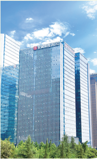
安诚财产保险股份有限公司总部大楼
