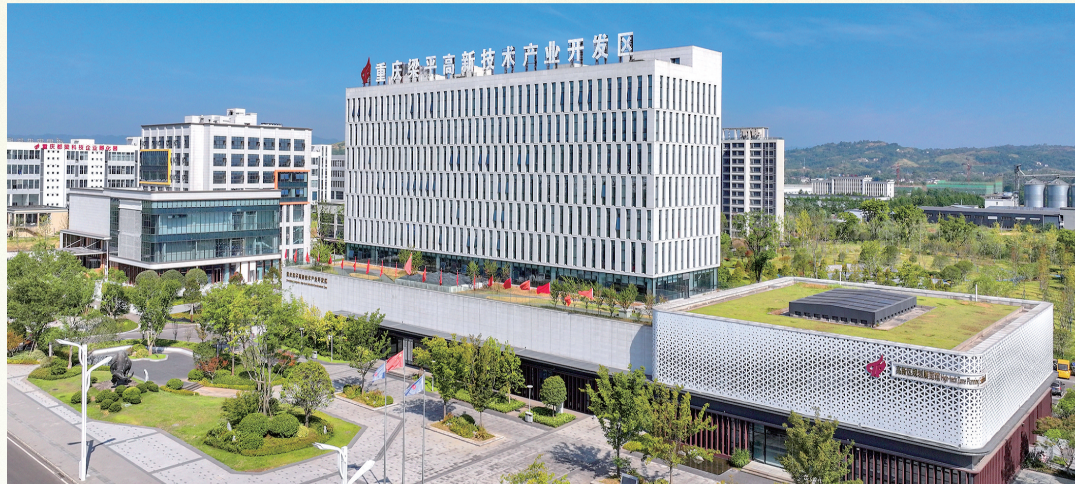
重庆梁平高新技术产业开发区 摄/熊伟
