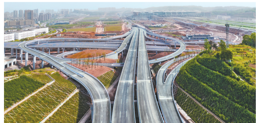
4月14日，南岸区茶惠大道施工现场。
