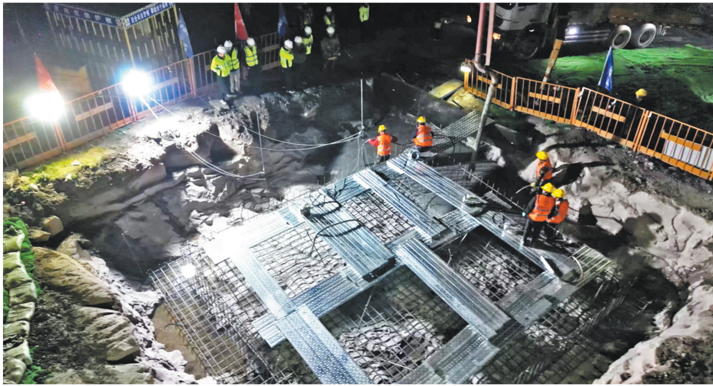
宜涪高铁重庆段主体工程施工现场。
