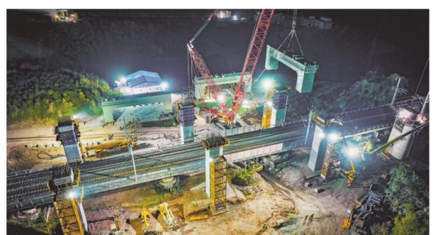
3月27日,在成达万高铁建设现场,施工人员在夜间进行高铁钢梁吊装作业。当日凌晨,在中铁三局承建的成达万高铁左线福寿跨渝万城际特大桥项目施工现场,一榀重达165.8吨的钢梁稳稳落在支座上,标志着成达万高铁首个跨既有高铁(郑渝高铁)钢梁吊装完成,为后续桥梁架梁奠定关键基础。
