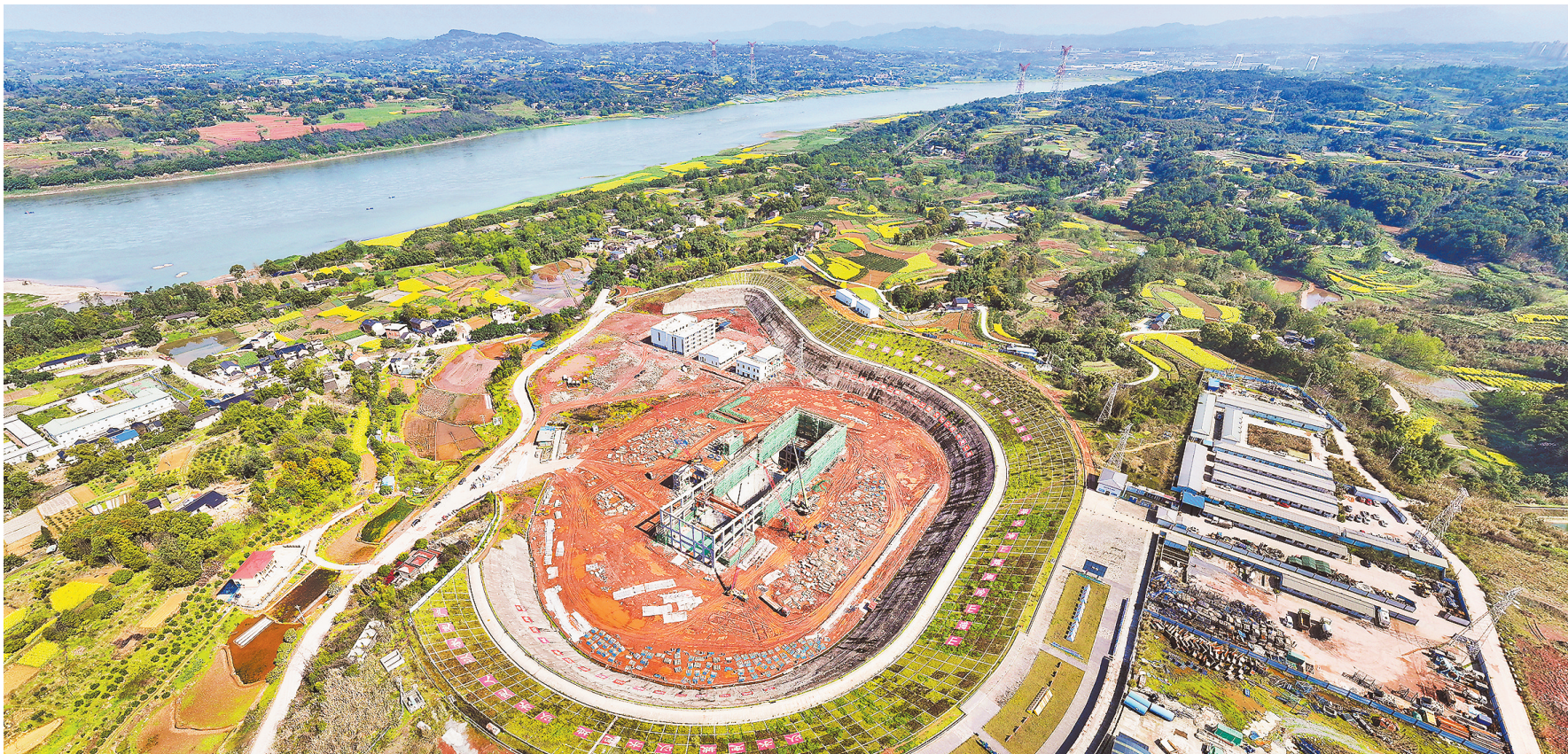
三月二十日，江津油溪金刚沱泵站施工现场，工人正加紧建设地面站房和地下管线。特约摄影 钟志兵 视觉重庆
