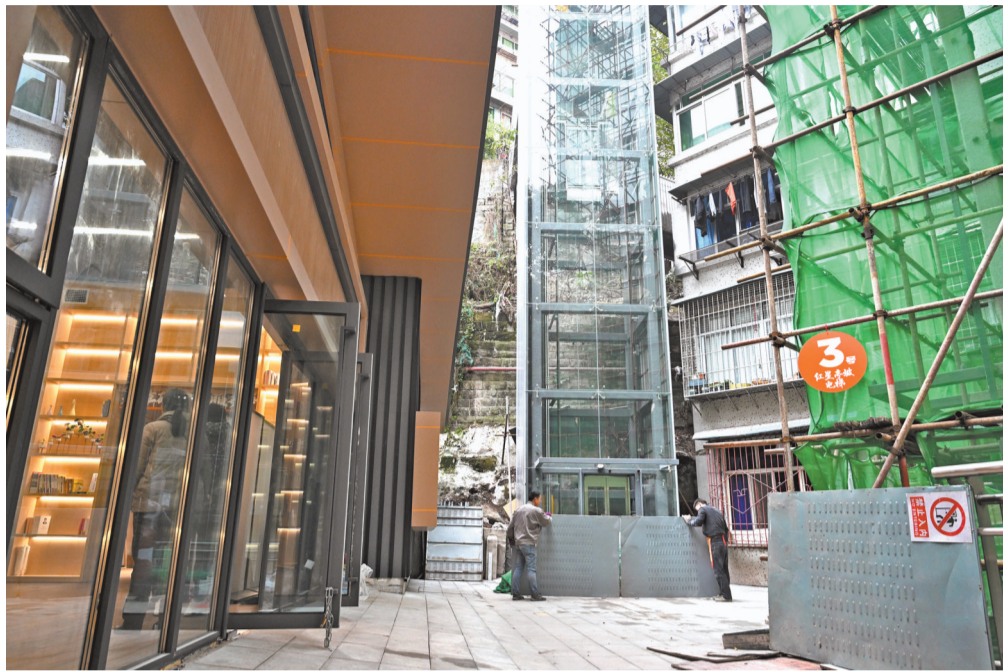
渝中区两路口街道红星亭坡小区，新建的无障碍电梯。(本报资料图片)
