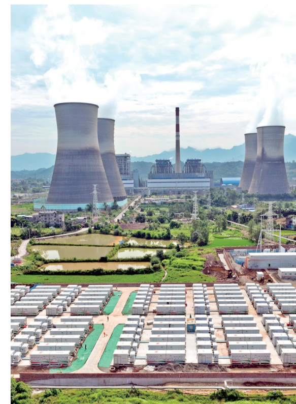
合川打造重庆综合能源及重要物资保障基地。图为合川双槐电厂 摄/周克春
