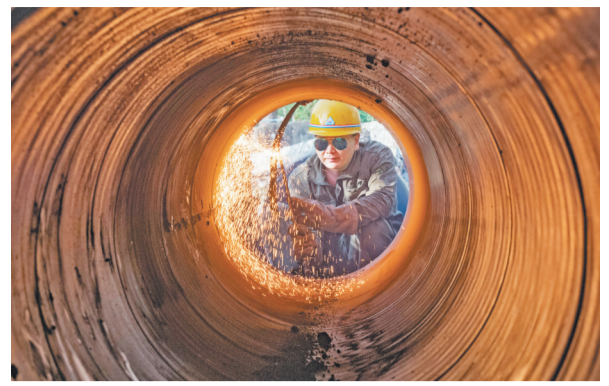
▲璧山水利工程施工现场,工人对管道进行作业。 受访者供图
