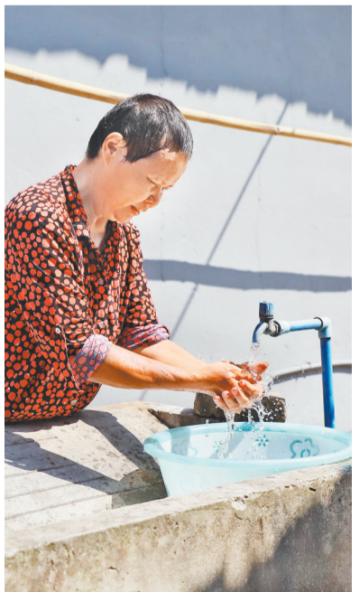
▲实施城乡供水一体化后,璧山群众用上了干净、平价的自来水。 受访者供图
