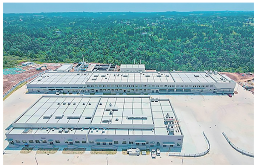
“潼南绿”冷链物流及城市配送中心一期工程项目完工
