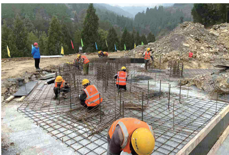
垫丰武高速公路下坪隧道施工现场,建设全力加速中
