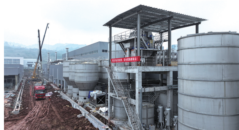
龙璟纸业二期建设现场
