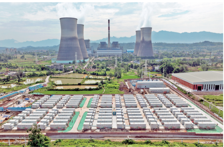
合川打造重庆综合能源及重要物资保障基地。图为合川双槐电厂。摄/周克春
