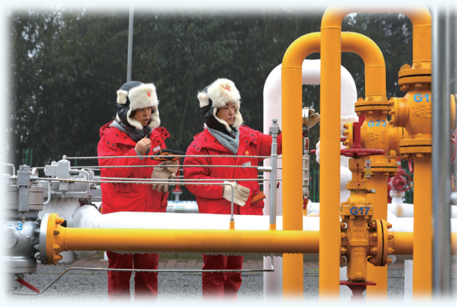
重庆气矿相14井员工在风雪中加密巡检保天然气输供安全 摄/郑元涛
