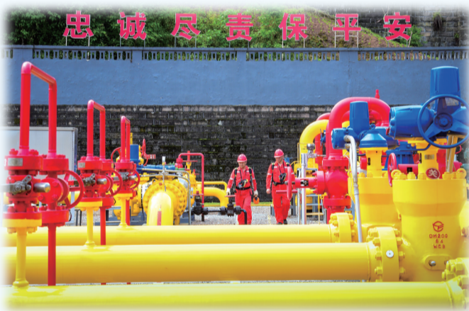
重庆气矿老湾增压站员工在巡检作业现场 摄/程红
