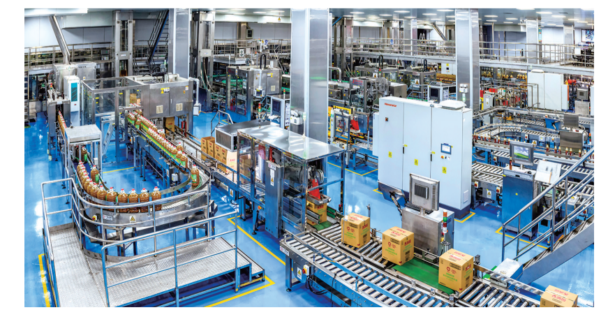
位于江津工业园区德感组团的益海嘉里智能工厂实现了从“入库”到“出库”全线智能化管控
