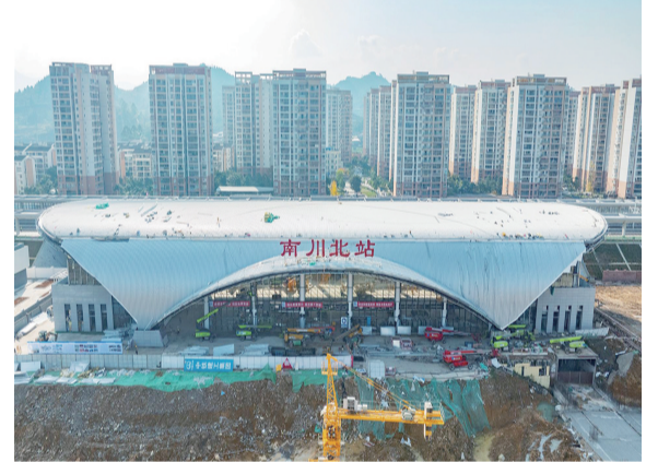
建设中的南川北站 摄/陈姗
