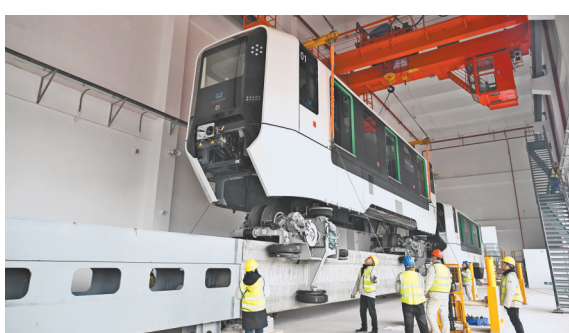
▲1月14日，重庆江北国际机场第八辆捷运“小火车”正在吊装上线，连接T3A—T3B的机场捷运系统正在进行动车调试及试运行。
