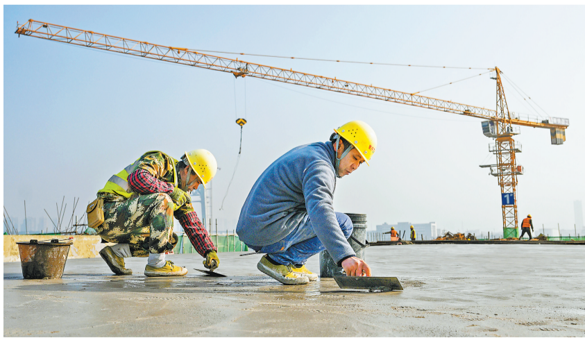
1月12日，位于南岸区鸡冠石镇的鸡冠石污水处理厂四期扩建工程现场，工人正在加紧施工。 记者 张锦辉 摄/视觉重庆
