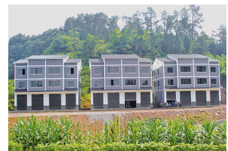
涪陵区商市街道石堡屋基滑坡避险搬迁新房
