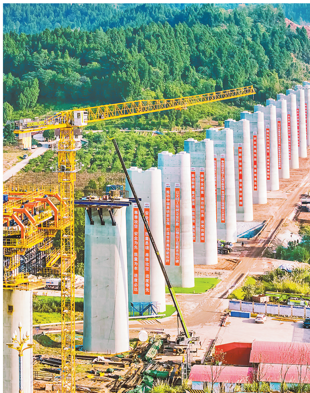
2024年12月1日，成渝中线高铁跨安岳大道特大桥连续梁主墩上，工作人员在抓紧施工。 四川日报C视觉摄影师 杨康忠 摄
