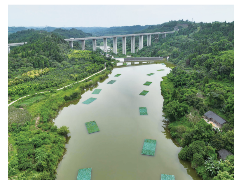
修复后的石壁沟水库
