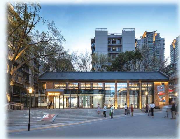
九龙坡区谢家湾街道民主村社区会客厅
