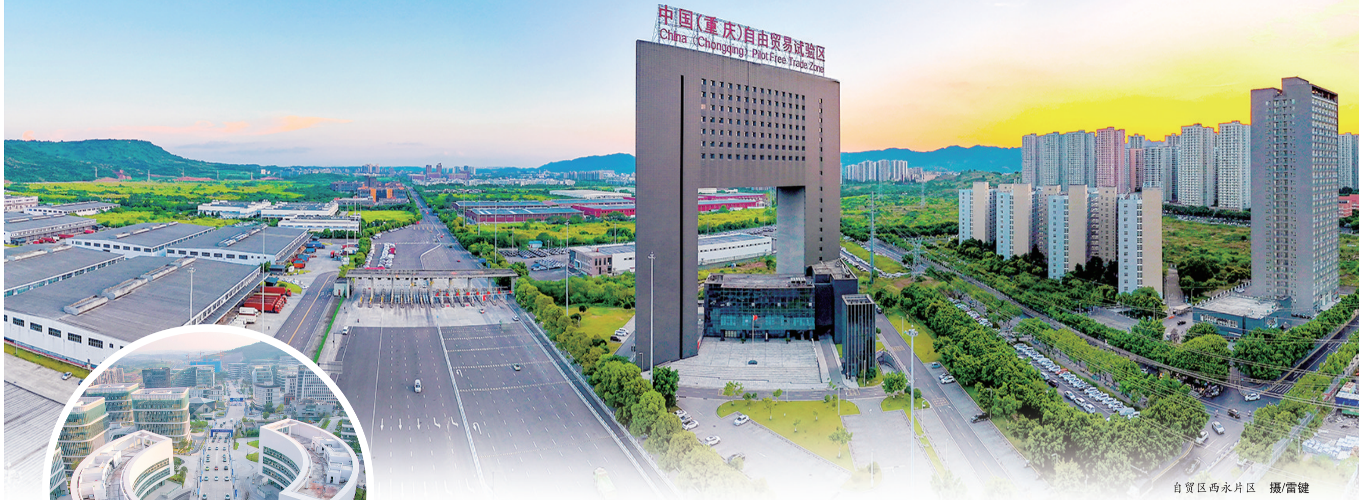
自贸区西永片区 摄/雷键
