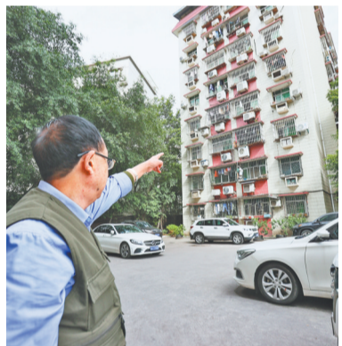
10月22日，北碚天生街道，“和颜茶室”退休老干部张才金指向处理漏水纠纷的居民楼。
