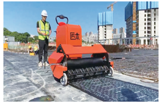
建筑机器人进行防水卷材铺贴施工
