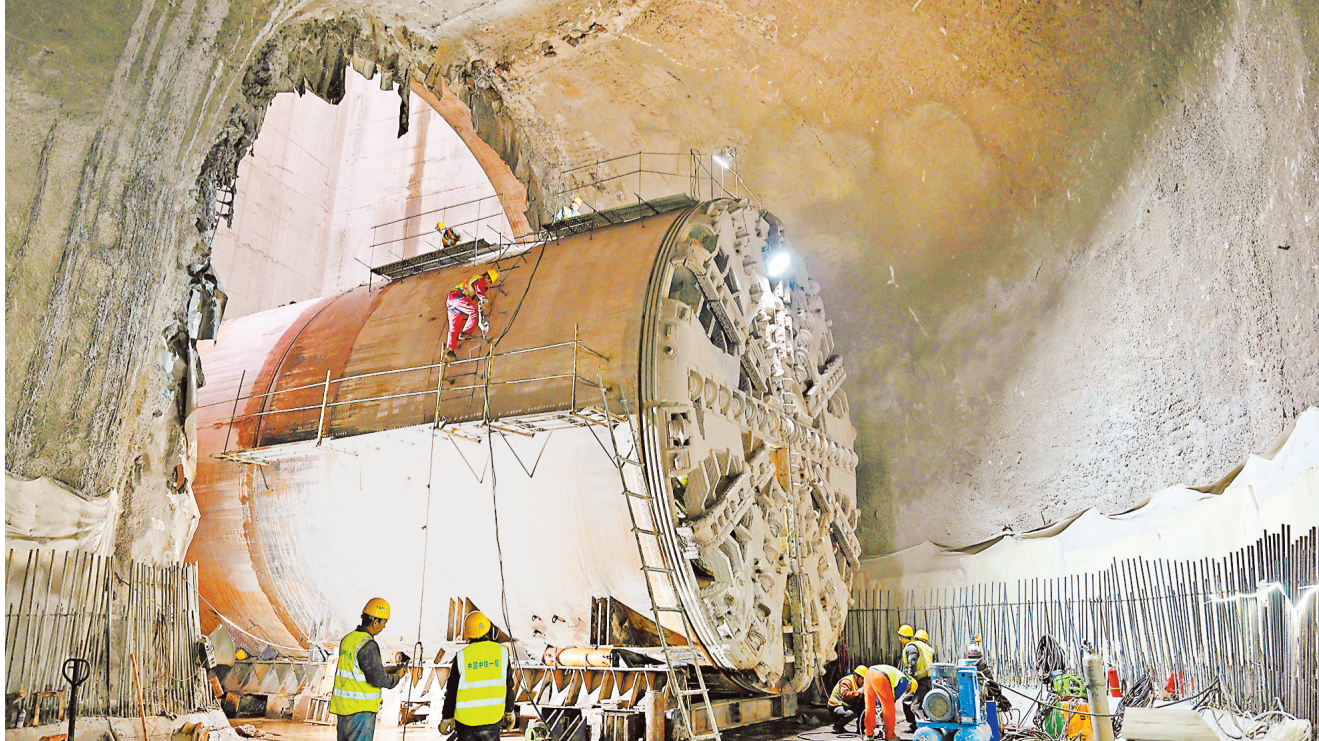
十一月二十五日上午，长江上游轨道第一隧“渝江号”盾构机进行拆解施工。图为技术工人正在对先期贯通的左线盾构机进行拆解施工。
