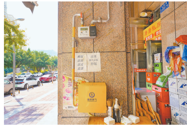
近日，市级公租房商业资产已完成燃气入户管道及气表安装工作。(市应急管理局供图)
