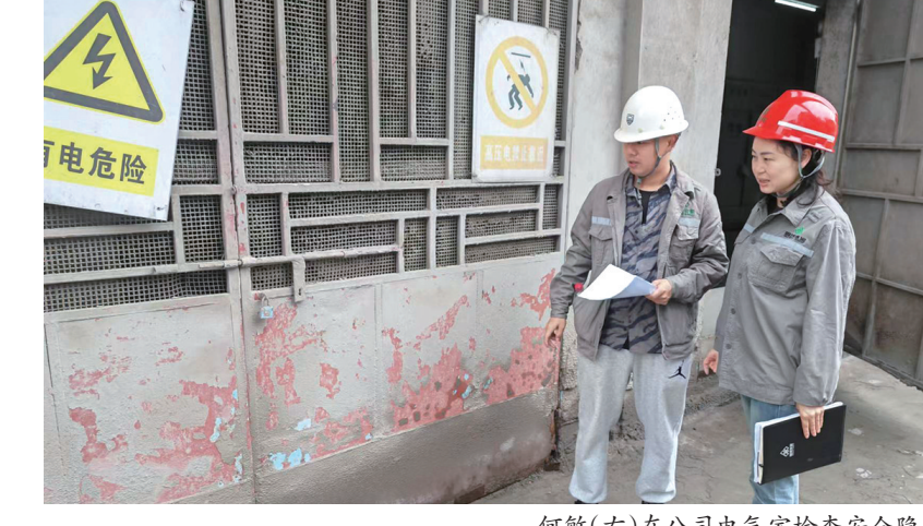
何敏(右)在公司电气室检查安全隐患
