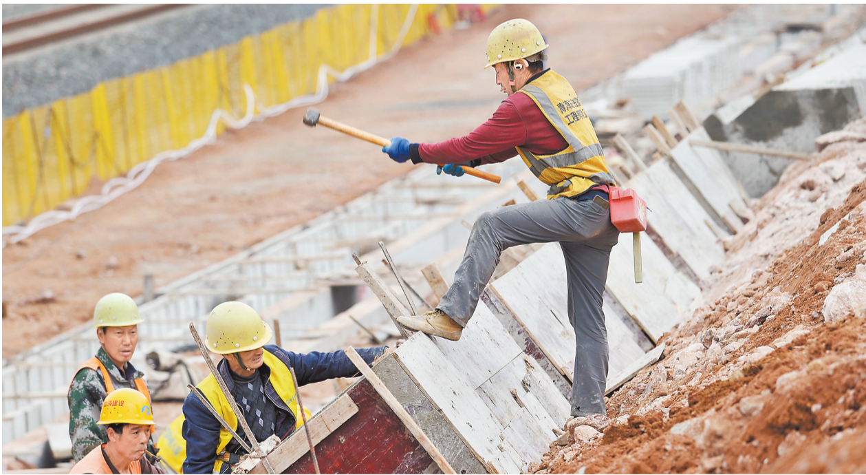
十一月十六日,黔江区,工人在渝厦高铁重庆至黔江段毛家坝段进行附属工程施工。
