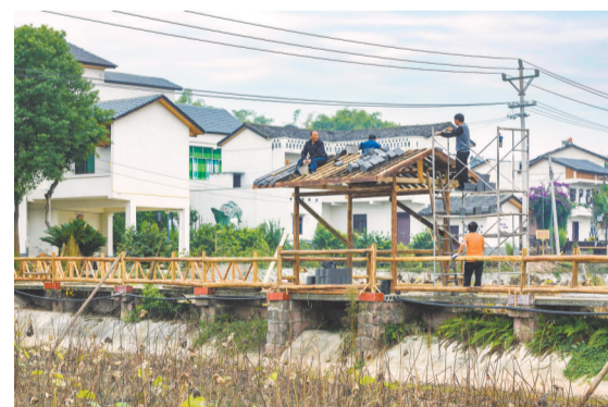
10月25日，璧山区七塘镇喜观村，村民正在迎客修建亭廊。
