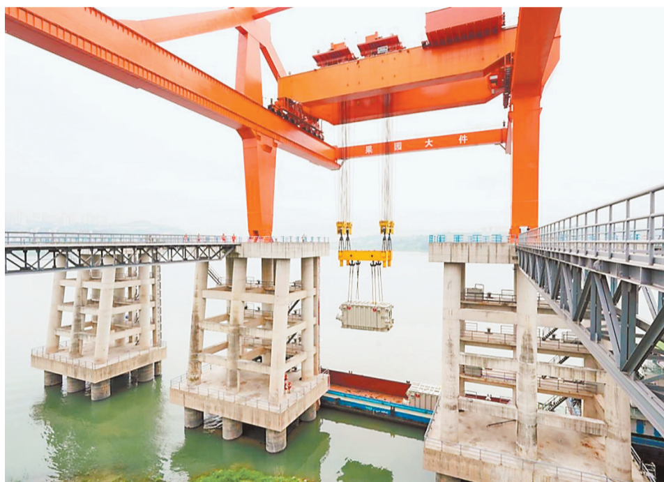
近日，果园港大件码头吊装渝北换流站变压器。
