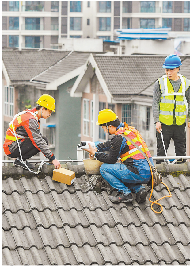
▲两江新区礼嘉街道嘉和社区，技术人员正在屋顶安装防高空抛物监控摄像头。 记者 张锦辉 摄/视觉重庆
