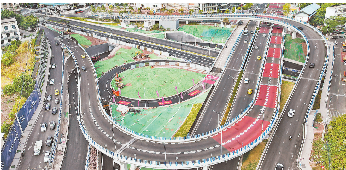
新建成的蚂蟥立交改造工程。（中铁二十局供图）
