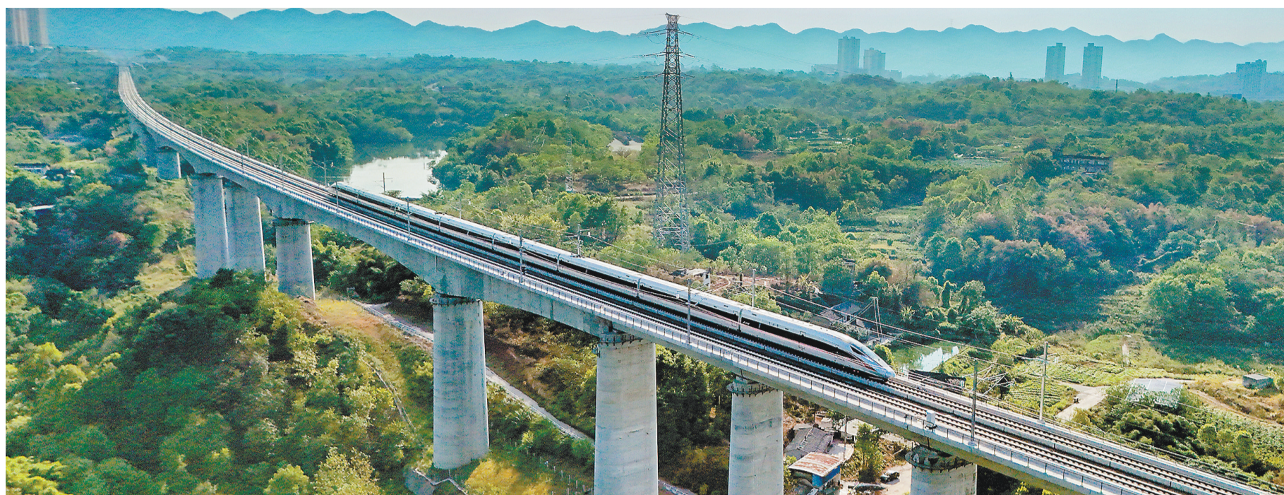
复兴号动车组列车驶过渝昆高铁九龙坡三百梯水库道岔特大桥。黄继吉 摄 视觉重庆
