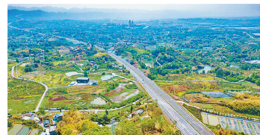
渝遂复线铜梁段。中铁建重庆投资集团供图
