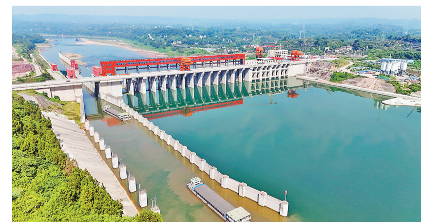
利泽航运枢纽。重庆高速航发集团供图
