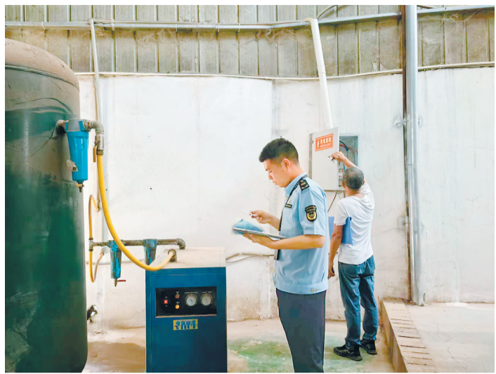
九月三十日，巴南区应急管理局执法人员在进行安全生产检查。（巴南区应急管理局供图）
