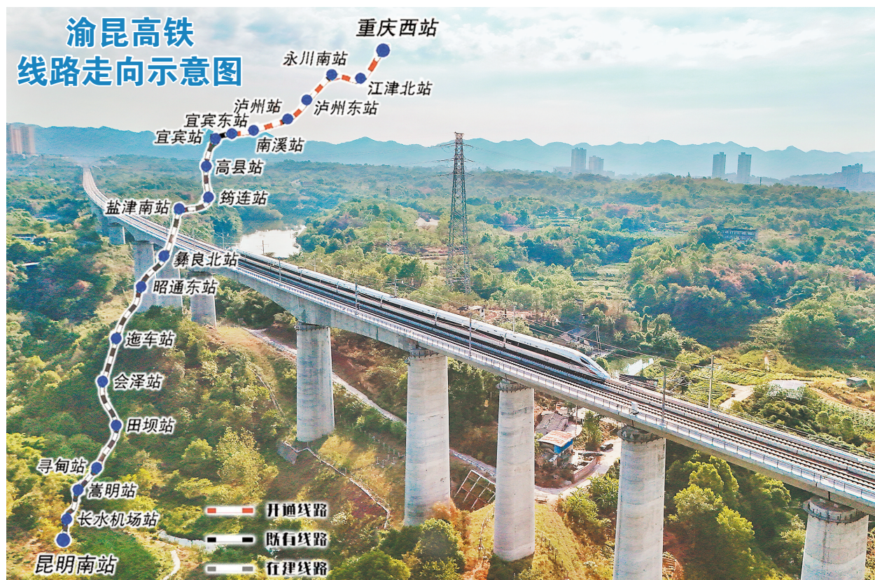
8月中旬试运行期间，复兴号动车组列车驶过渝昆高铁九龙坡三百梯水库道岔特大桥。通讯员 黄继吉 摄/视觉重庆
