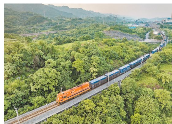
▲班列驶出位于长寿区的渝巴铁路集装箱区。(摄于2024年6月12日)
