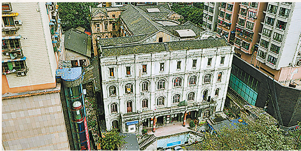
即将开工修复的聚兴诚银行旧址。
