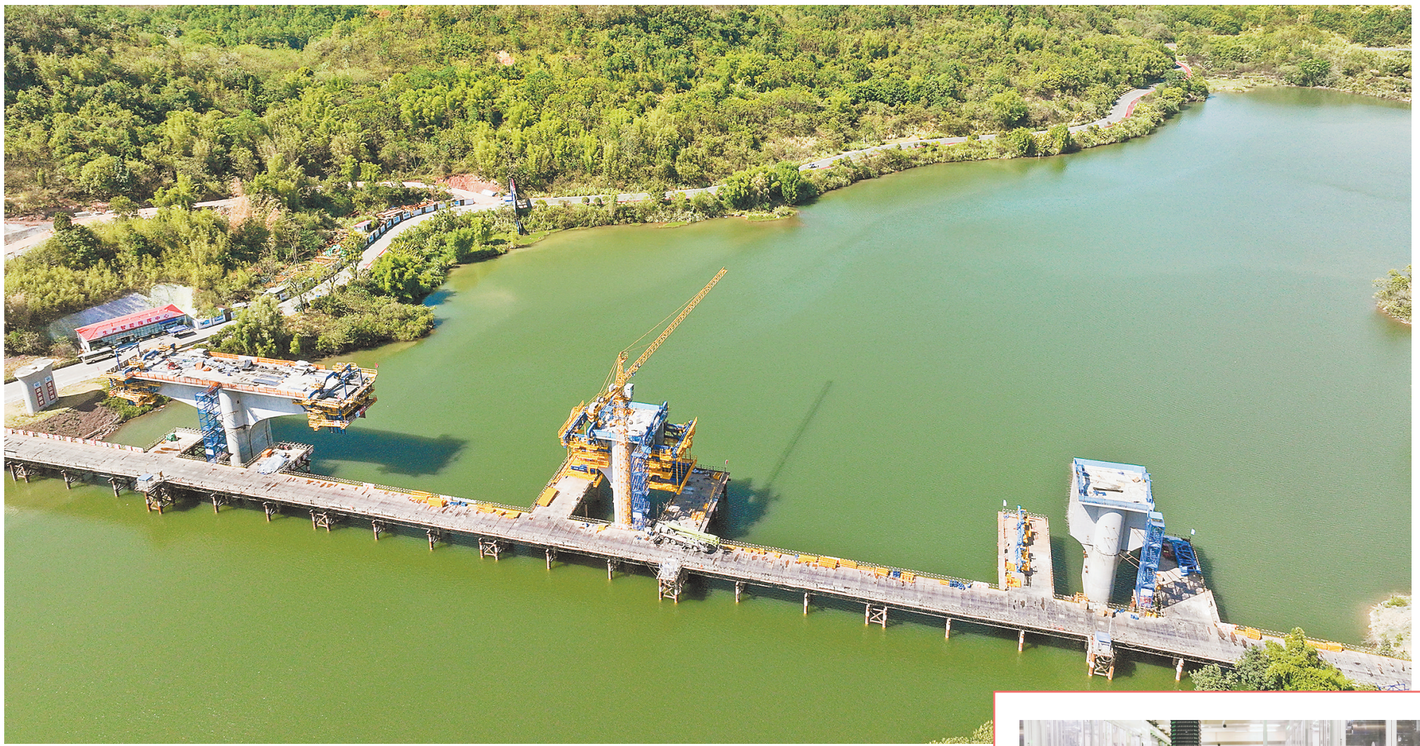
九月三日，位于铜梁区的成渝中线高铁双溪天湖双桥建设现场。
