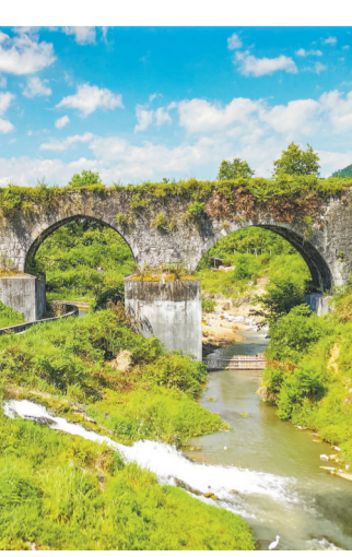
巨丰堰三拱桥渡槽。
