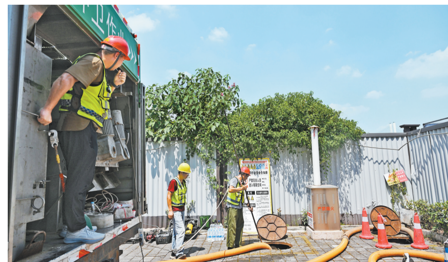
清掏化粪池 消除安全隐患
