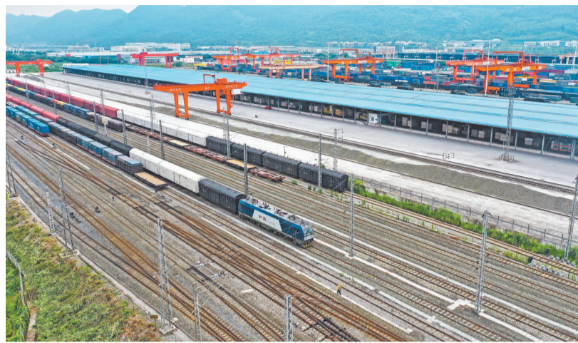
一列满载着来自东南亚货物的X9578次西部陆海新通道铁海联运班列抵达沙坪坝区团结村站。
