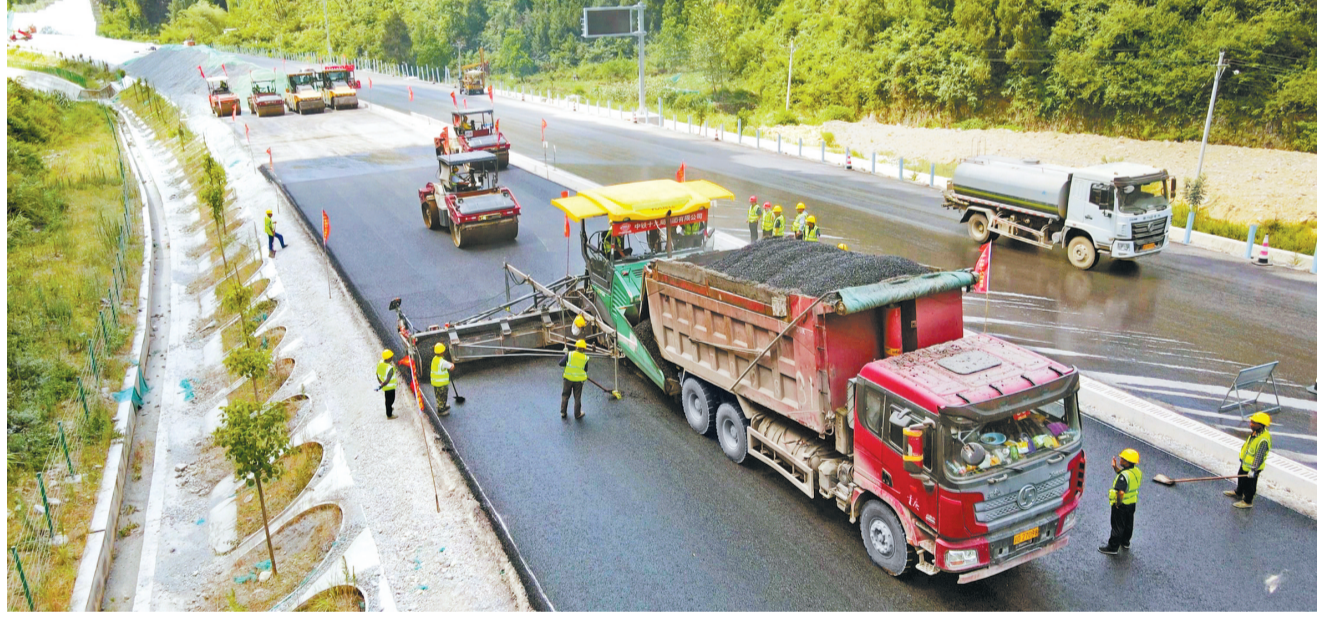
八月七日，渝湘复线高速彭西路沥青路面摊铺现场，施工人员正在作业。通讯员 樊志航 摄/视觉重庆
