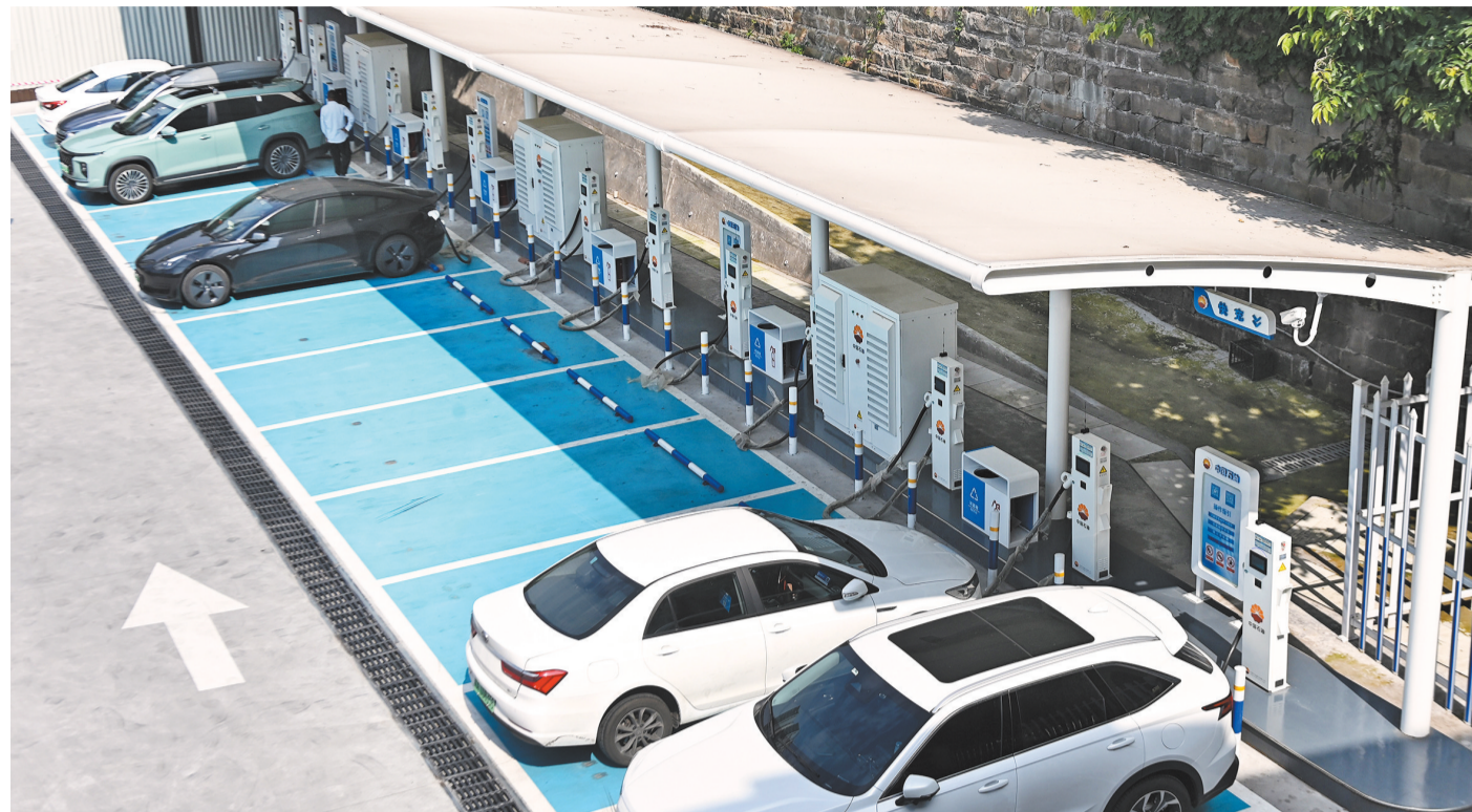
六月十三日，位于沙坪坝区的站西路充电站。该充电站于今年二月建成投用，配备十二台单枪分体式直流快充终端、两台液冷超充终端，能够满足十四台电动汽车同时充电，最快充电速度达“一秒一公里”。 特约摄影 孙凯芳/视觉重庆
