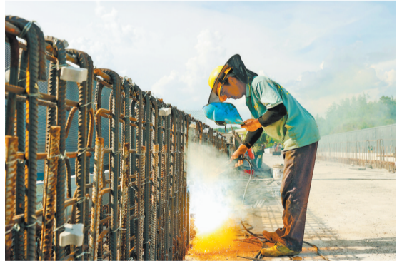
8月6日,渝湘高铁重庆至黔江段黔江区葡萄沟大桥上,建设者错峰施工,抢抓时间,确保按时完成工期。特约摄影 杨敏/视觉重庆
