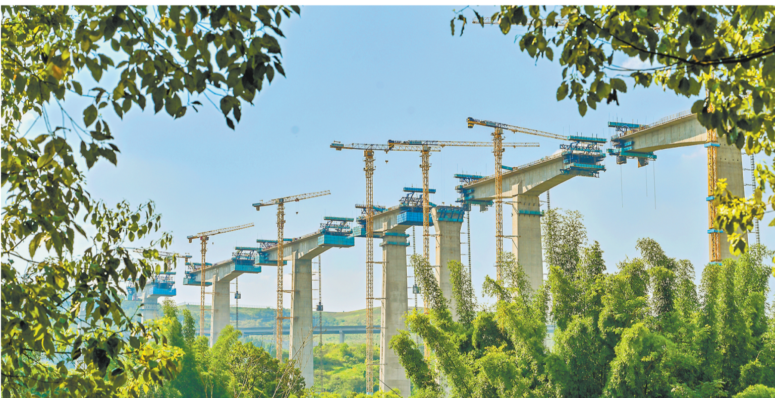
8月6日,重庆轨道交通15号线一期T3航站楼站至龙骏大道站区间建设现场,建设者采取早晚作业等方式应对高温天气,保障项目有序推进。首席记者 龙帆 摄/视觉重庆
