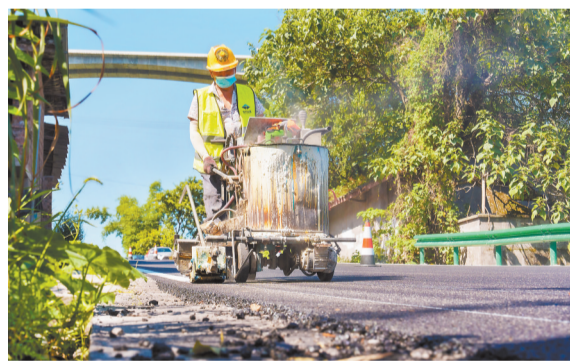
八月二日,北碚区龙王街,施工人员进行道路维护。 记者 李雨恒 摄影/视觉重庆
