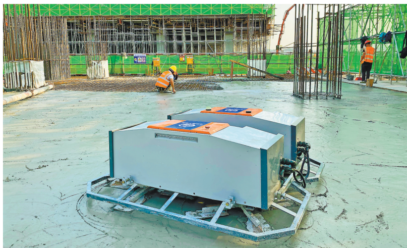
重庆东站施工现场，四盘地面抹光机器人（中铁建工集团重庆东站供图）
